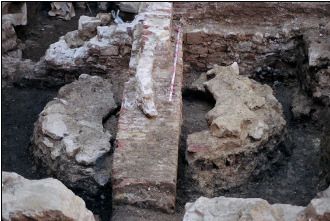
Mur de riosta construït amb maons massissos en forma d'arc a plec de llibre
