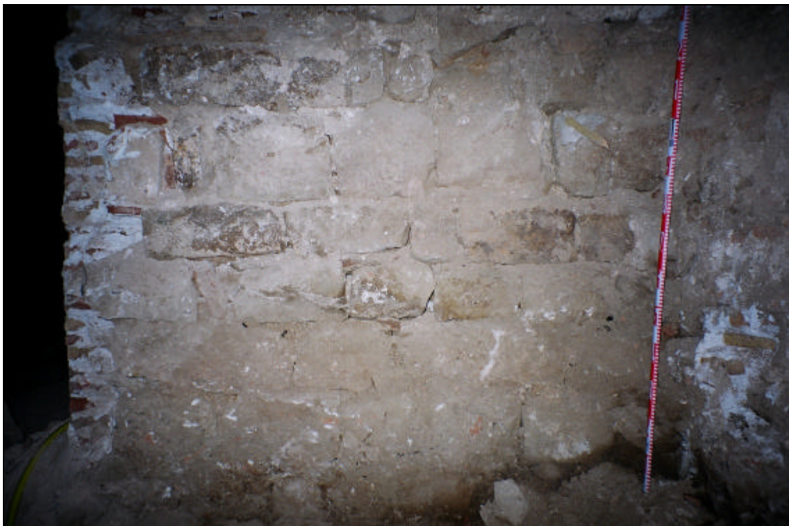
Vista d'un mur medieval (Sector 1/7) reaprofitat en l'estructura de l'edificació projectada el 1851.
