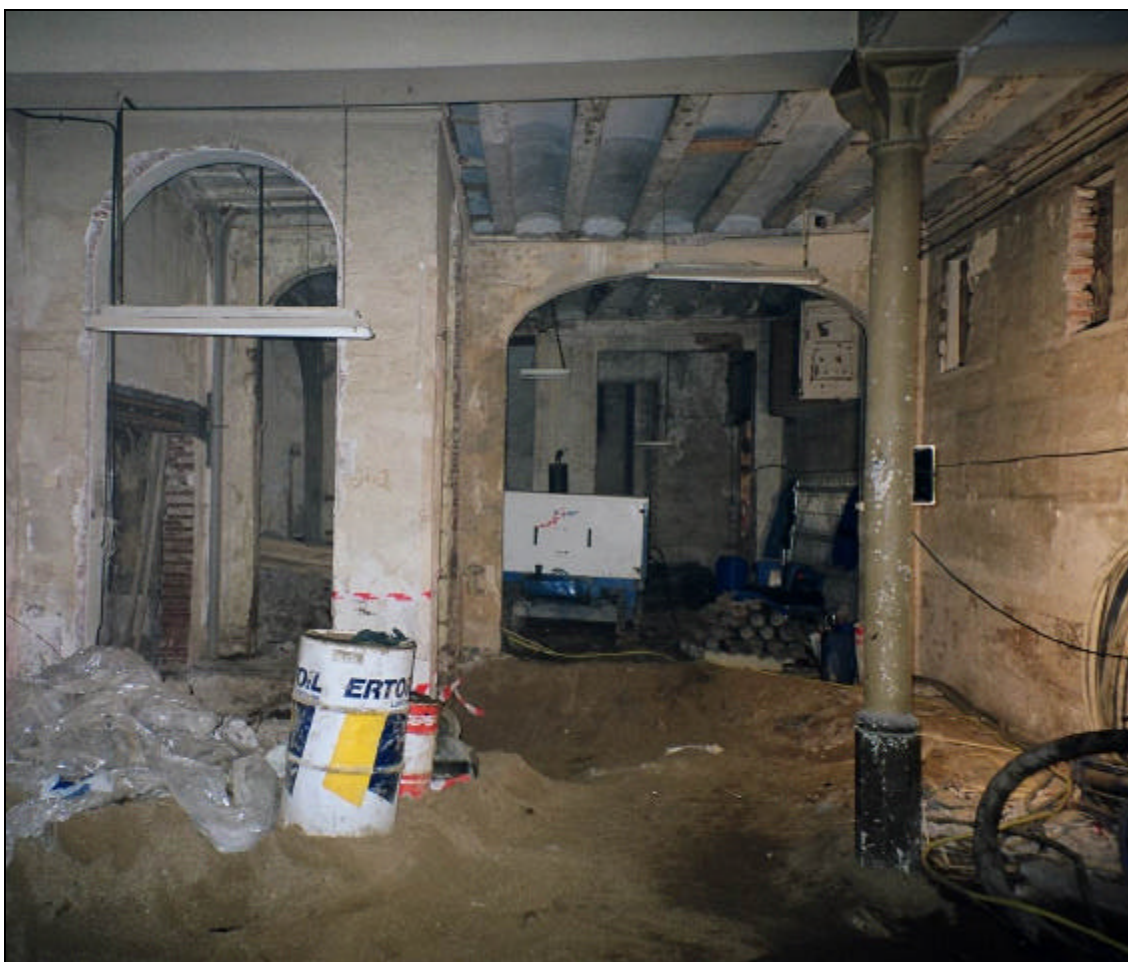
Vista de l'interior de l'edifici (Sector 1/2) abans d'iniciar-se l'enderroc de la finca, punt on es trobava l'escala de connexió entre els edificis (a l'esquerra de la imatge)
