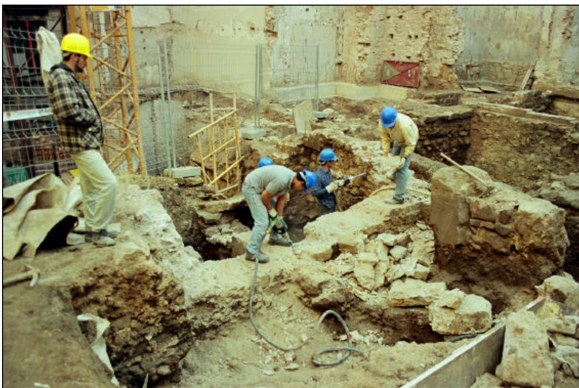
Control del desmuntatge de les riostes amb martells pneumàtics
