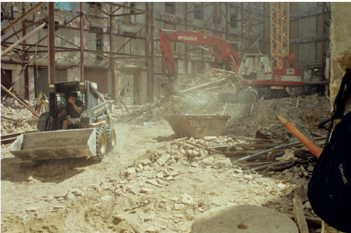
Interior de la finca número 3 poc abans d'acabar l'enrunament de l'interior de l'edifici
