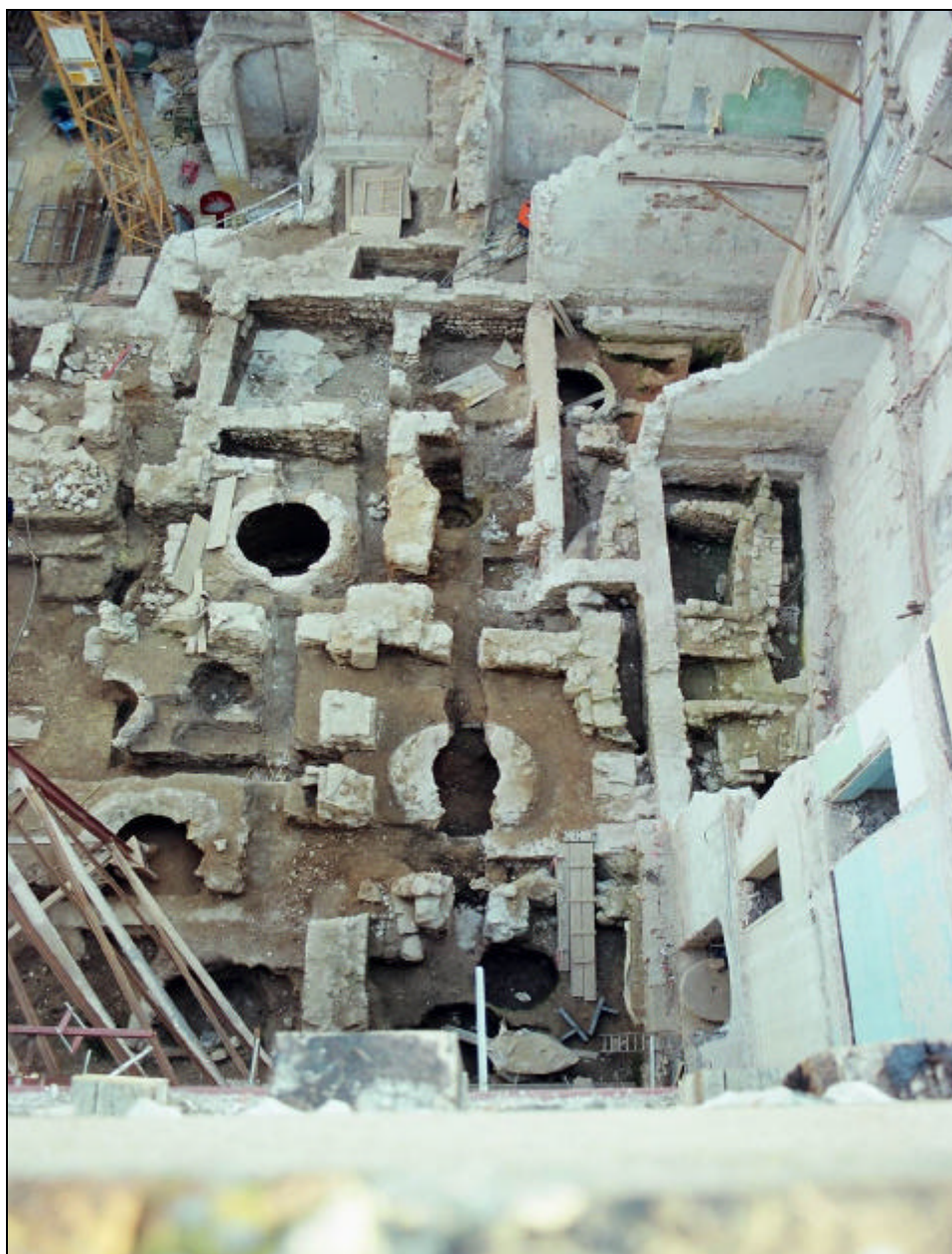
Vista del jaciment un cop eliminades part de les riostes fins a la profunditat determinada per l'obra
