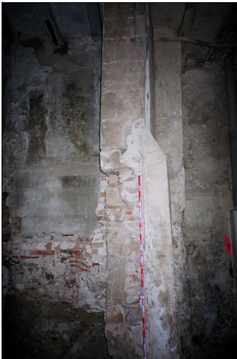
Mur d'època medieval construït amb carreus situat en el sector 1/7 i emmascarat en la distribució de la finca projectada l'any 1851
